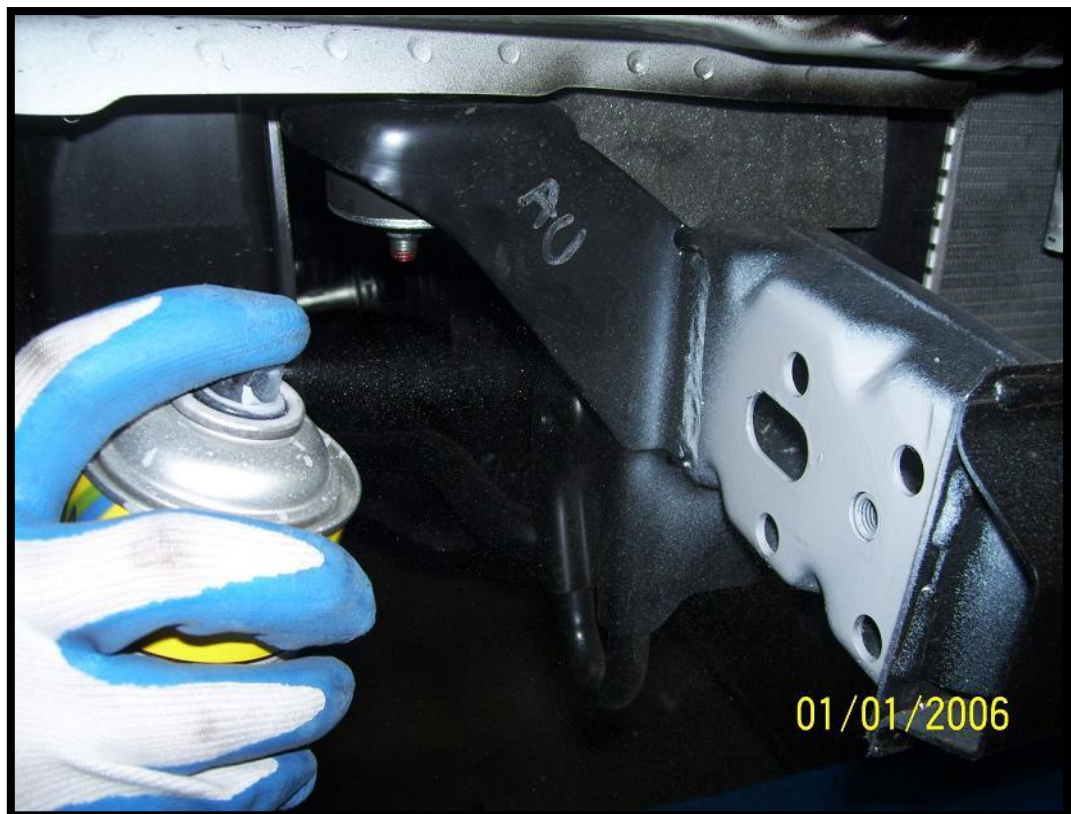
Czyszczenie środka z wiórów i nakładanie podkładu Cleaning the inside of shavings and the imposition primer
