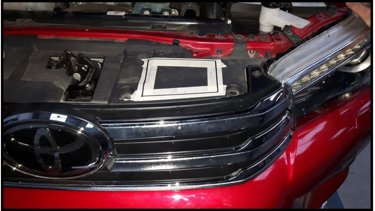
Wycinanie otworu dostępowego do sprzęgła. Cutting the access hole for the clutch.
