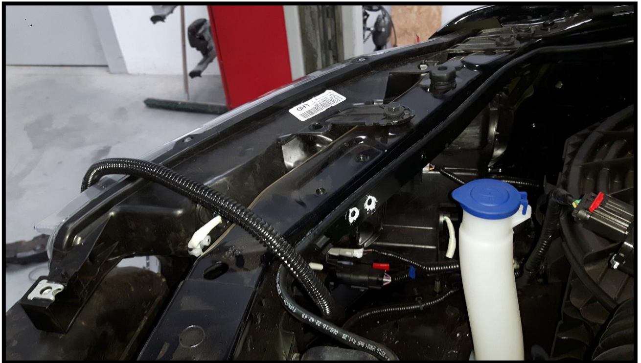
Montowanie pilota. Zabezpieczyć podkładem przed korozją. Mounting control switch attachment. Protect against corrosion with primer.
