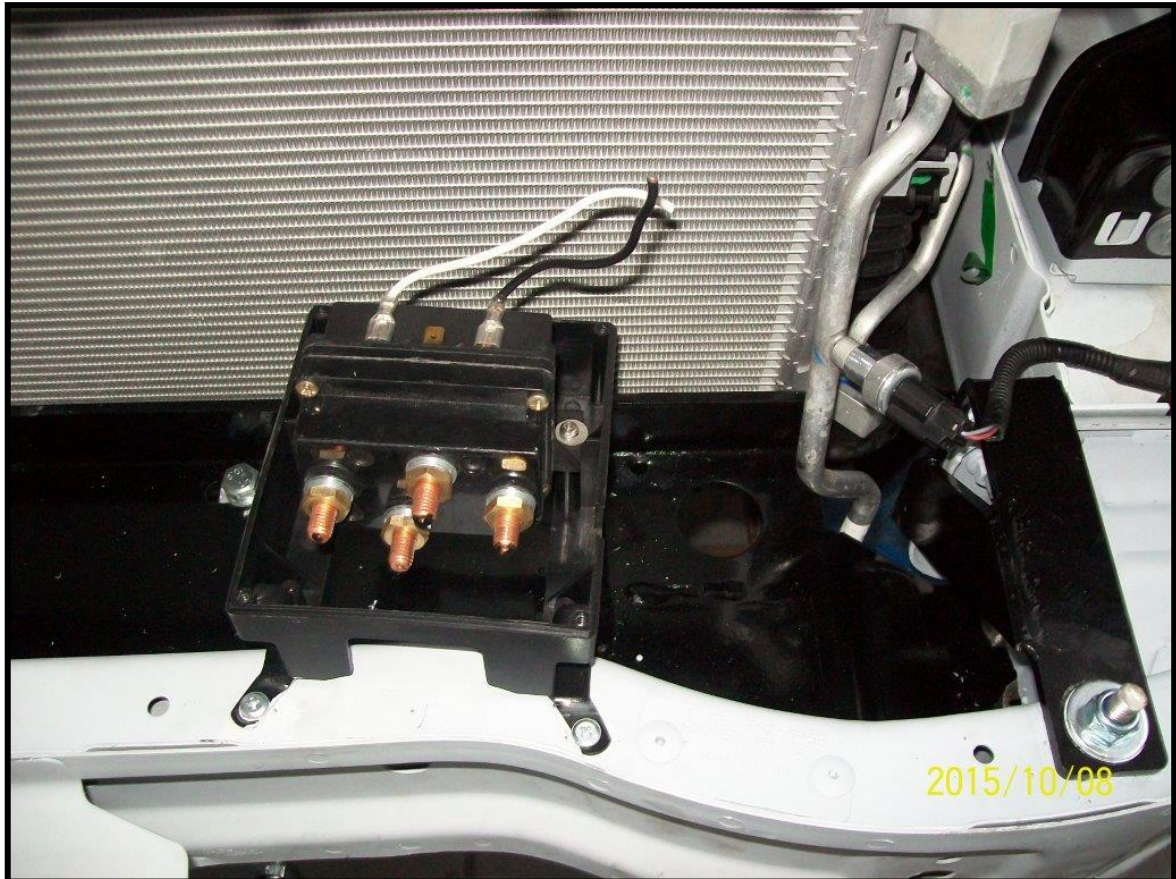
Montowanie przekaźnika. Mounting the relay.
